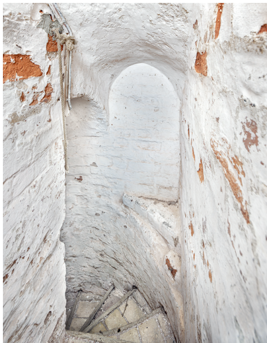
Fig. 14. Trappehusets indre set mod øst (s. 4417). Foto Arnold Mikkelsen 2024. – Stairwell interior, looking east.
