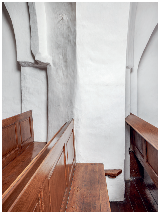
Fig. 15. Hvælvpiller mellem langhusets andet og tredje fag (s. 4417). Foto Arnold Mikkelsen 2024. – Vault piers between the second and third bays of the nave.
