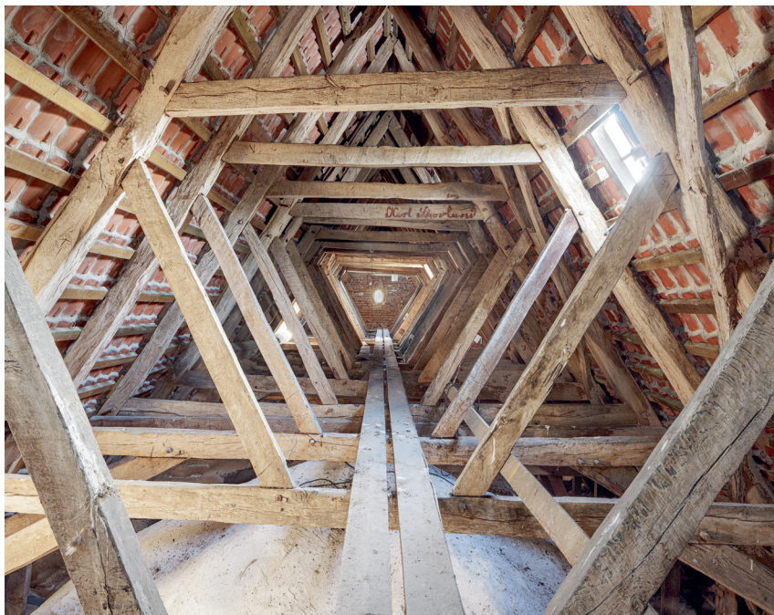
Fig. 21. Skibets tagværk set mod øst (s. 4428). Foto Arnold Mikkelsen 2024. – The nave's roofing, looking east.
